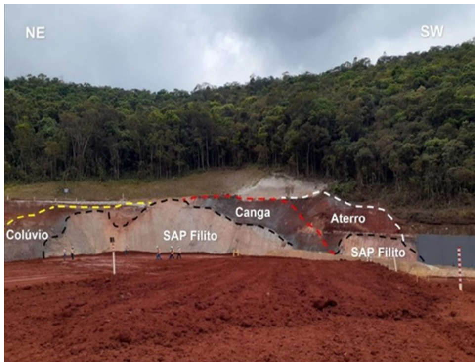
Figura 108 Talude esquerdo da barragem, onde se observa a base da escavação coberta por material de aterro compactado. Acima, aparecem camadas de saprólito de filito, sobrepostas por depósitos coluvionares, canga ferruginosa e material de aterro. Fonte: VALE, 2023.
